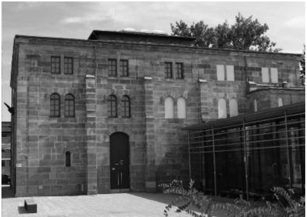
Abb. 2: Große Halle von Süden – Untere Fensterreihe gegenüber Urzustand z.T. verändert
