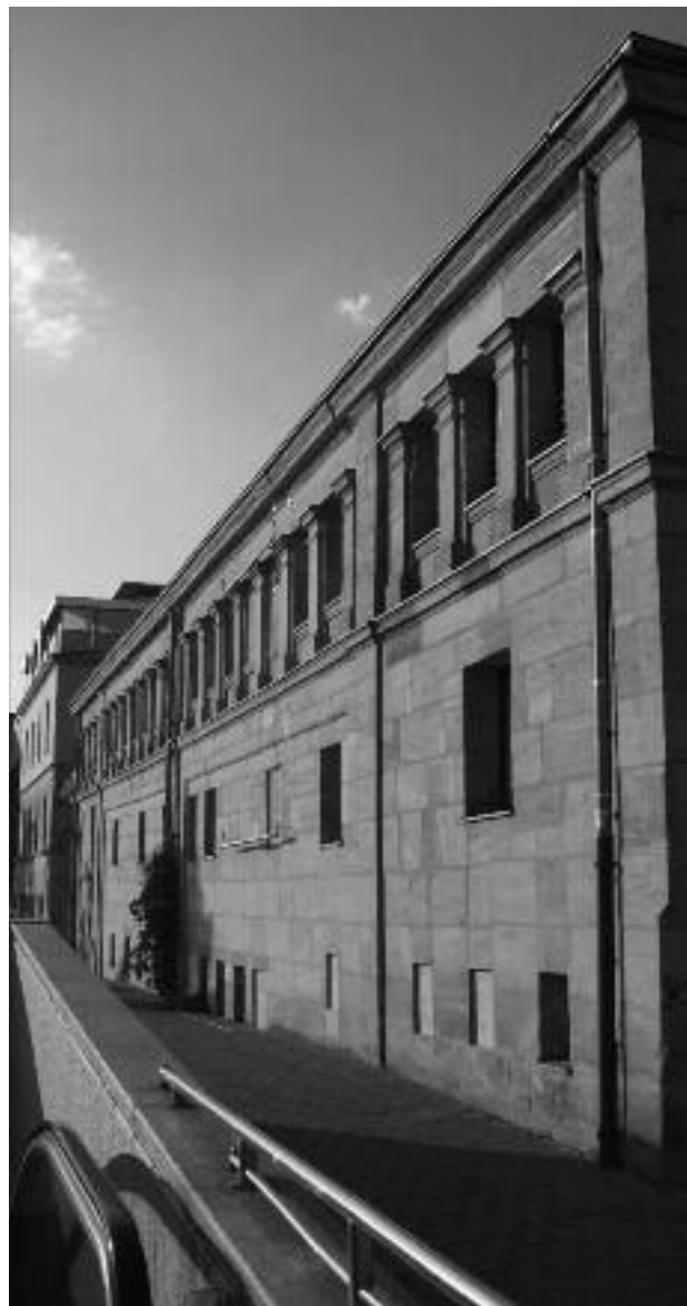
Abb. 6: Straßenfront des Südtraktes vom Eckbau aus (l. umgebauter ehemaliger Verwaltungsbau)
