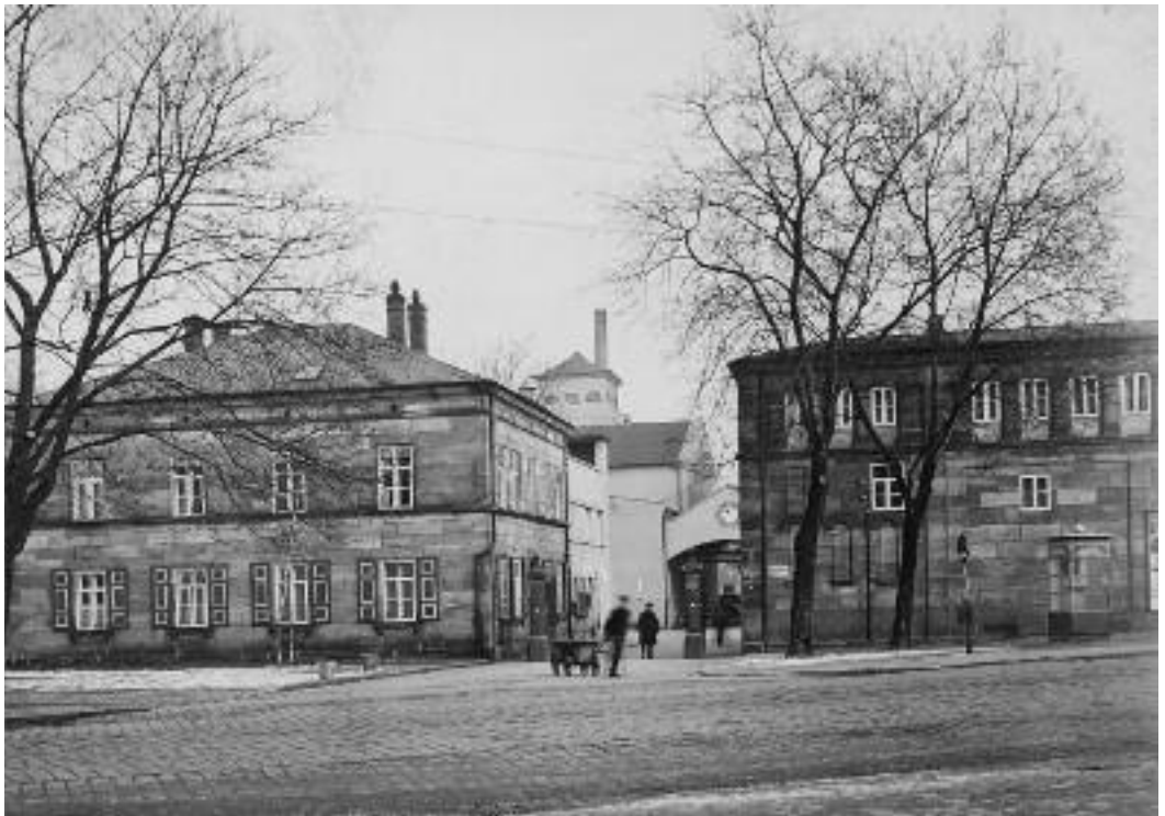
Abb. 10: Verwaltungsgebäude an der Würzburger Straße zwischen 1930 (Aufstocken des Anbaus) und 1949 (Aufstocken Hauptbau), rechts der Südflügel
