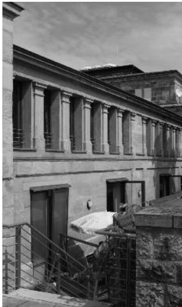
Abb. 5: Der Sandstein- Mitteltrakt mit neuen Türen und neuer Gastronomie- Terrasse am Fluss
