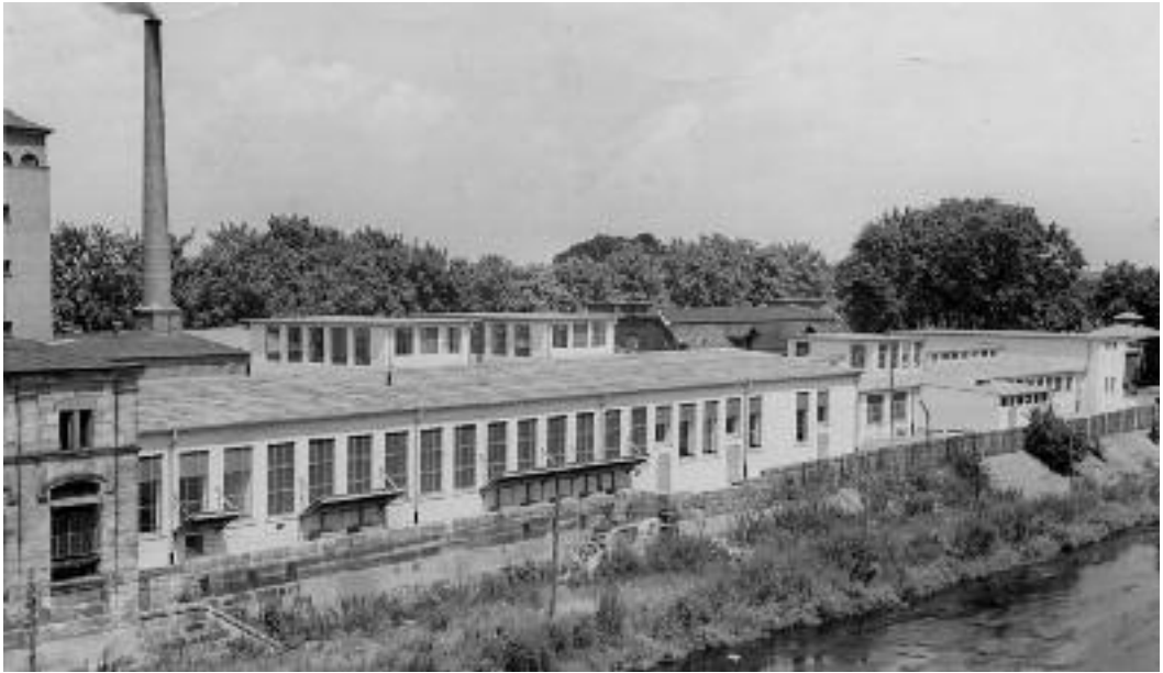
Abb. 13: Zu Nr. 4 a/b/c des Textes – Nachfolgebauten von 1950 für zerstörten Nordflügel: Neue Rinderschlacht-halle/ -stall (Aufnahme Wolkenstörfer, 1950)
