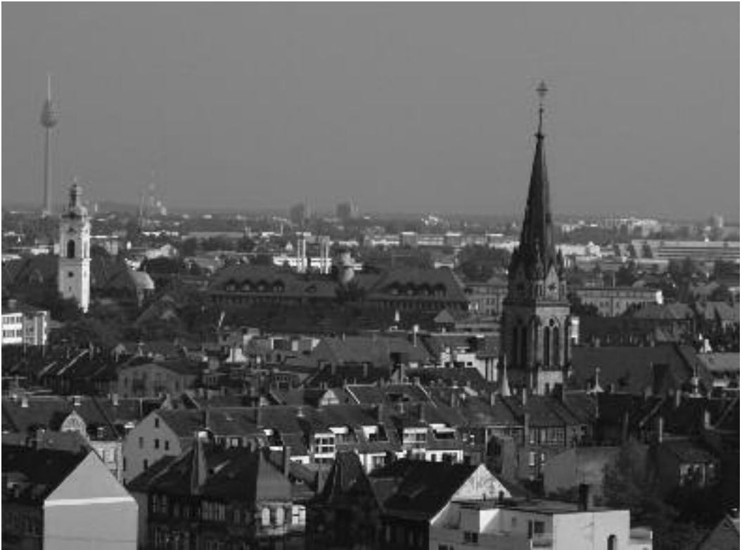
Blick über die Südstadt, ab 1870 für die wachsende Bevölkerung angelegt mit Wohnungsbauten, Schulen und Kirchen. Links die Heinrichskirche (1910), rechts die Paulskirche (1900).
