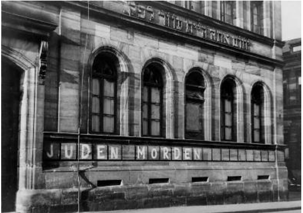
Waisenhaus-Fassade nach dem 9. November 1938
