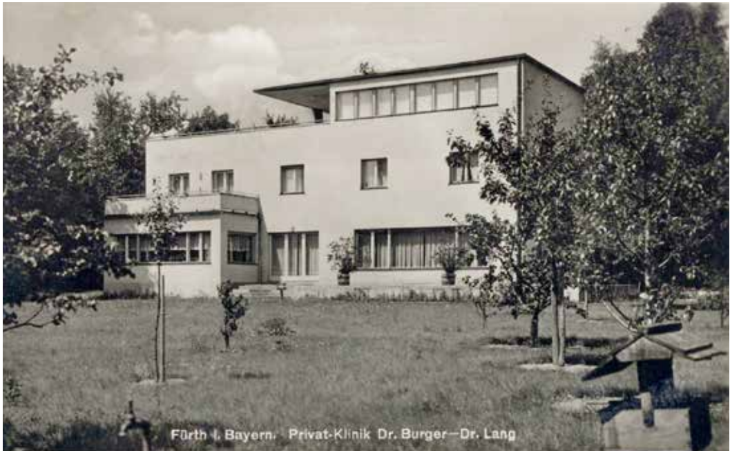
Abb. 20: Haus Cahn, Schwedenstraße 19
