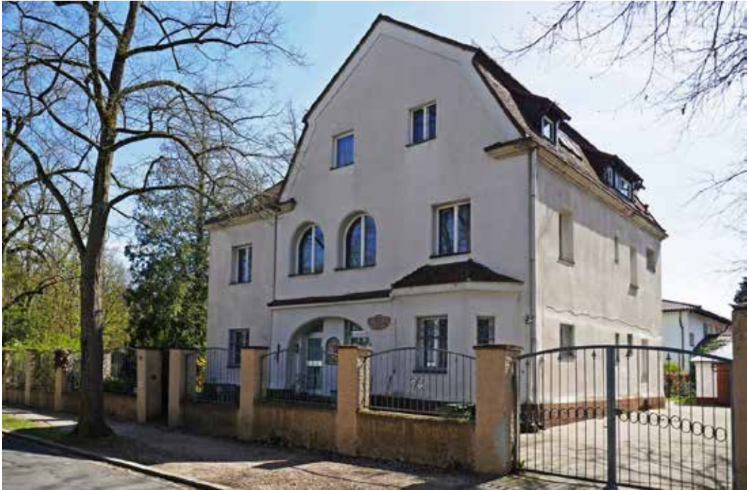
Abb. 14: Das Bauprinzip der Asymmetrie gehört auch zum Jugendstil. Villa Lindenstraße 9, erbaut 1909, Foto 2023.
