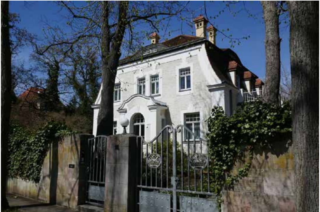
Abb. 9 und 10: Die Häuser signalisieren in ihrer aufwendigen Bauweise die hohe soziale Schicht der Bewohner. Villa Lindenstraße 18, erbaut 1902, Fotos ca. 1920 und 2023.
