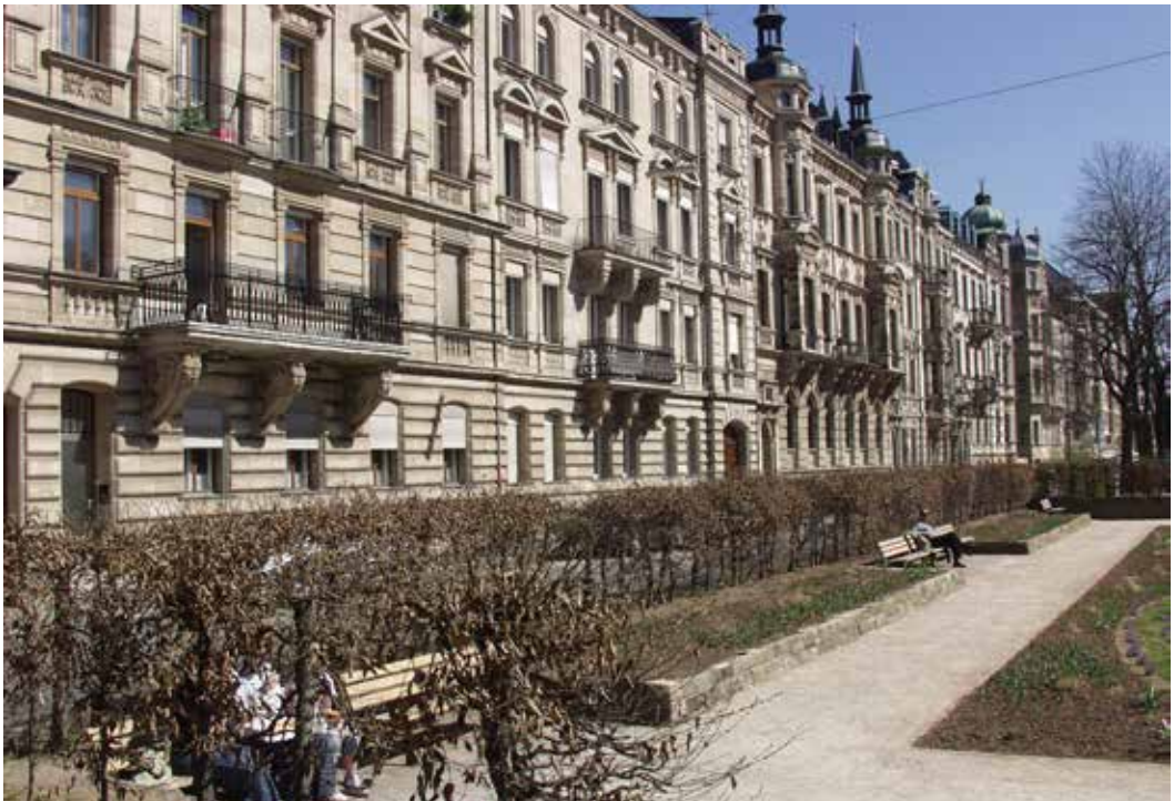
Abb. 3: Auch die Hornschuchpromenade wurde in geschlossener Bauweise errichtet, Foto 2001.
