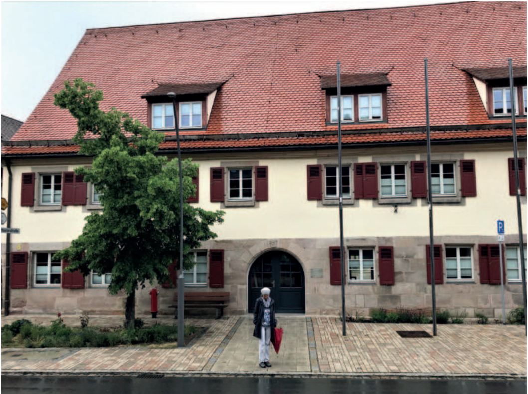
Abb. 19: Das ehemalige Spital in Langenzenn, aktuelle Front zur Friedrich-Ebert-Straße
