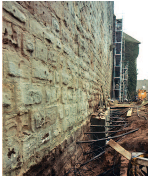
Abb. 3: Verankerung der Ringmauer mit Bohrpfehlen und Betonring, 1983.
