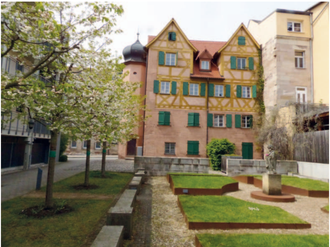
Abb. 14: Theaterstraße 33 von der Gartenseite.
