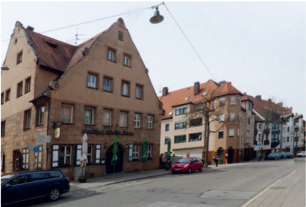
Abb. 23: Blick vom Gasthof Weiße Rose auf den neuen Häuserblock Königstraße 58 (mit Eckturm) bis 54.
