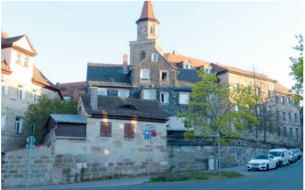
Abb. 6: Blick auf die Gebäude im Schrödershof, Hangseite rechts: „Einfuhr“.
