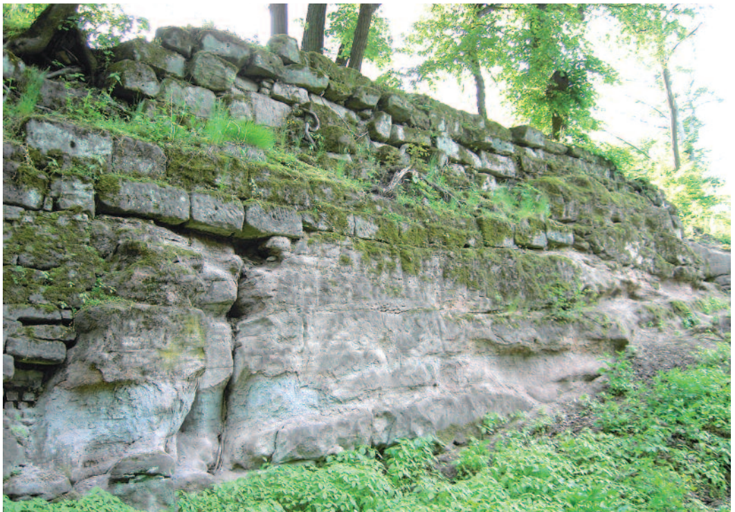
Abb. 30: Das Nürnberger Zerstörungswerk an der Westmauer, oben: Innenseite der inneren Mauerschale; unten über dem Felsen: Rest der abgekippten Außenschale
