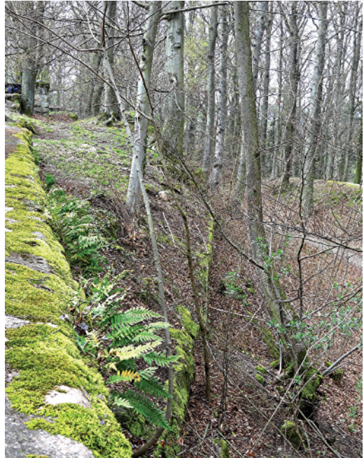
Abb. 7: Blick von der nordöstlichen Streichwehr nach Westen
