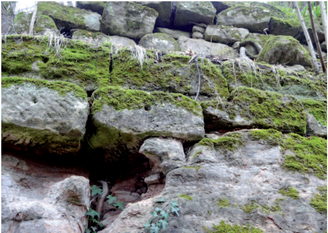
Abb. 12: Steinlagen der Außenfront an der Westseite
