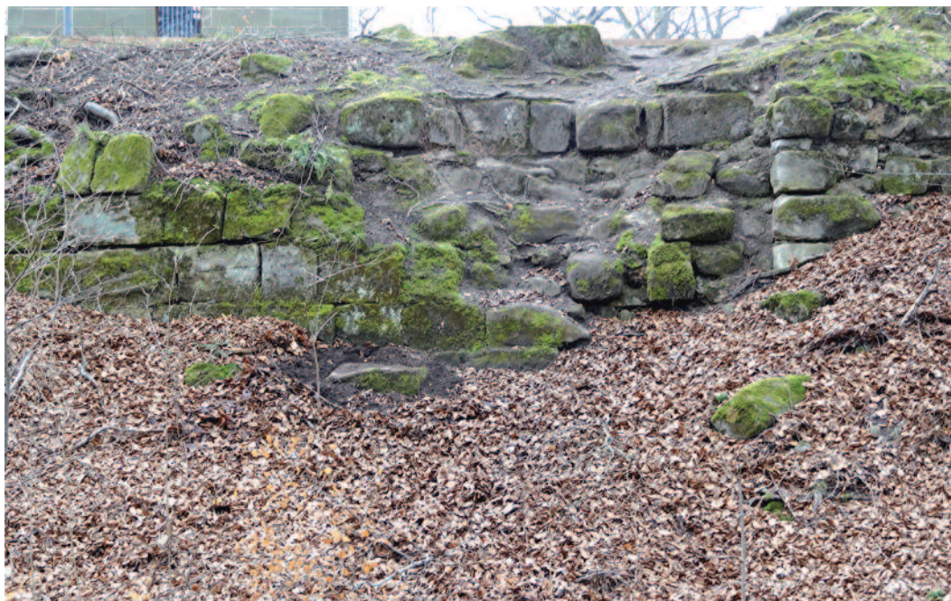
Abb. 13: Eine der Schadensstellen von 1388 an der Nordmauer
