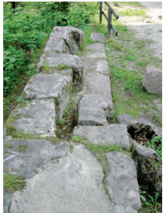
Abb. 11: „Schalenmauer“
