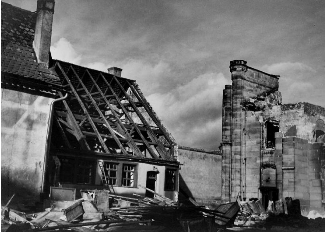
Zerstörte Hauptsynagoge und Nebengebäude, 10. November 1938
