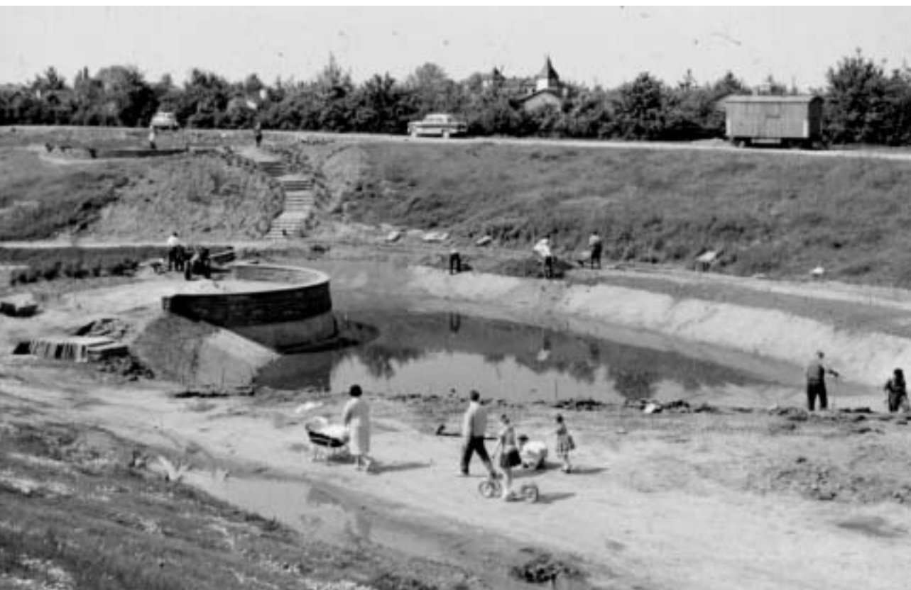
Abb. 139: Klein-Mainau. Trinktempel und Weiher im Bau.
