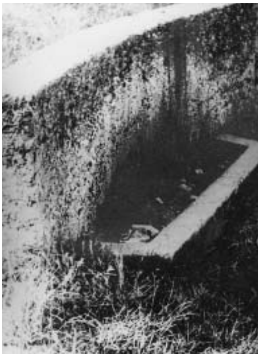
Abb. 136: Zerstörter Brunnen der Espanquelle am Kanaldamm, 1945.
