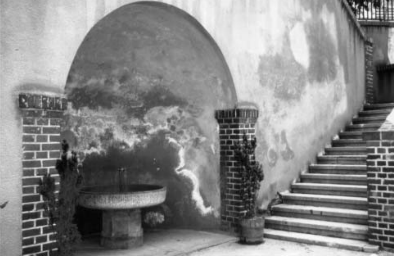
Abb. 128: Trinkbrunnen unterhalb des Aussichtspavillons, 1970.
