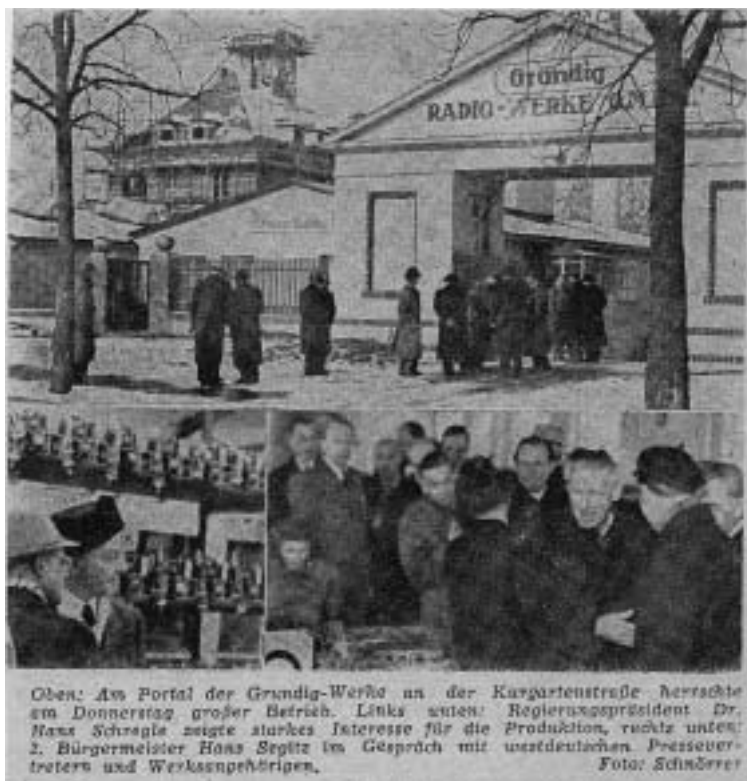
Abb. 121: Presseempfang am 3.3.1949. Das Gebäude des heutigen Rundfunkmuseums im Rohbau.
