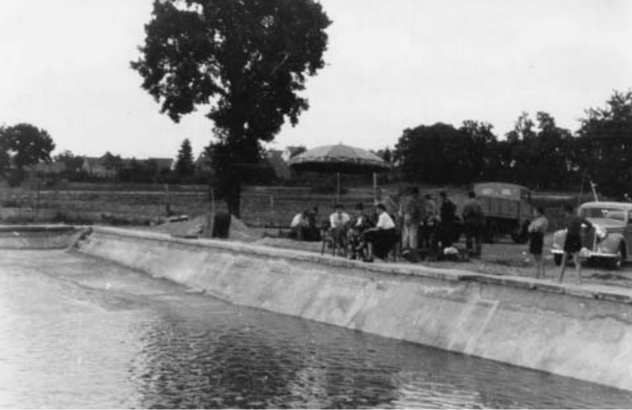
Abb. 153: Das neue Schwimmbecken wird eingelassen, 1952.
