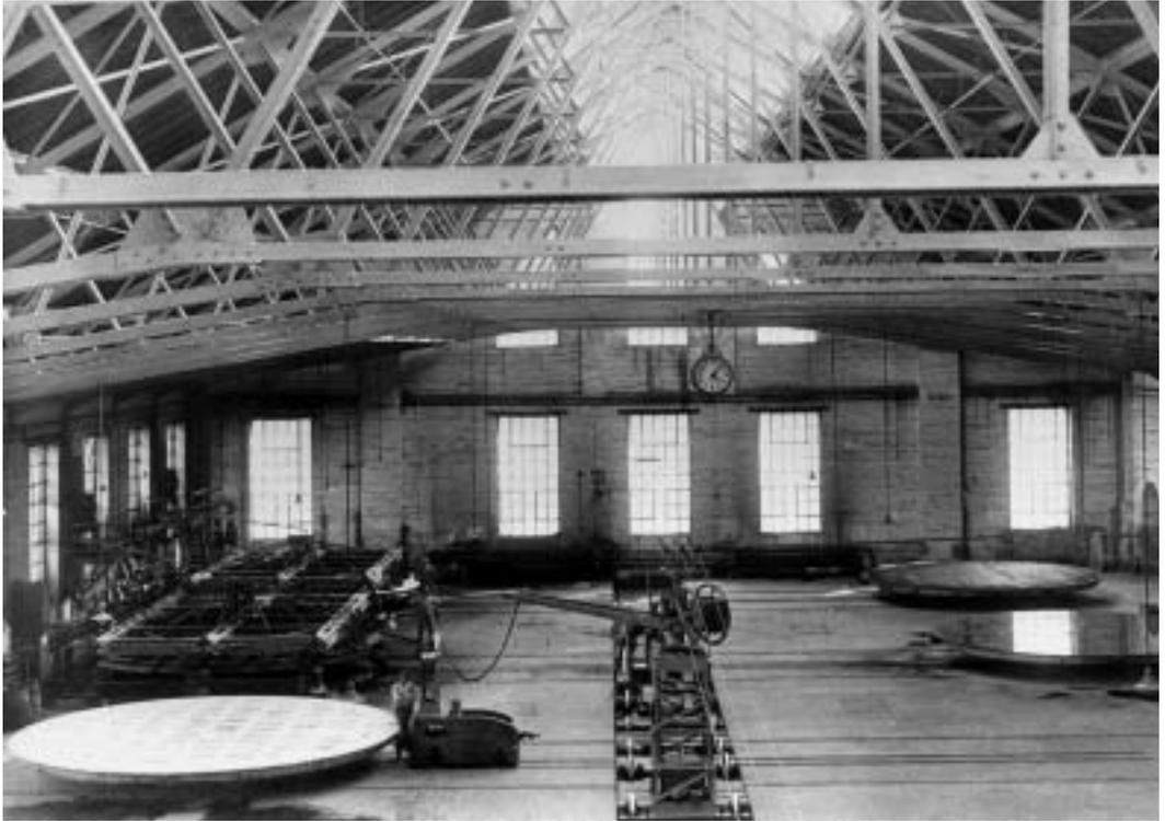
Abb. 5: 8-Meter-Poliertische mit elektrischer Zugmaschine und Elektromotoren von 200 PS; Marktredwitz um 1920.
